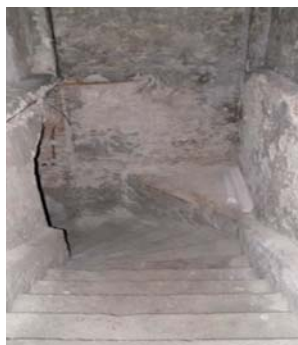
A felújítás előtti állapot:
